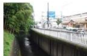
緊急輸送路に隣接した護岸（竹原堤）
