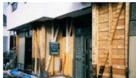
木造家屋耐震補強工事の例
