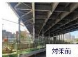
橋脚の耐震補強
