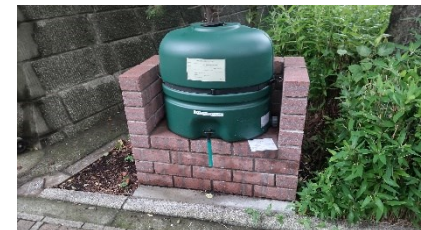
水やり用給水タンクの設置
